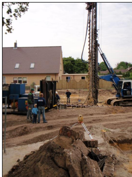
Afbeelding 2. Aanbrengen van de boorpalen
