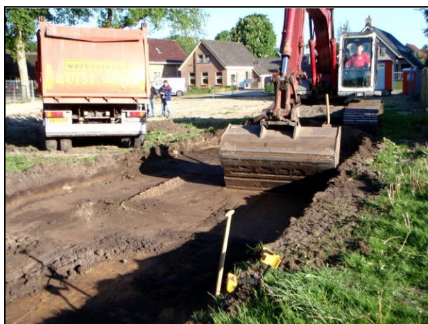
Afbeelding 3. Aanleg van het eerste vlak in werkput
